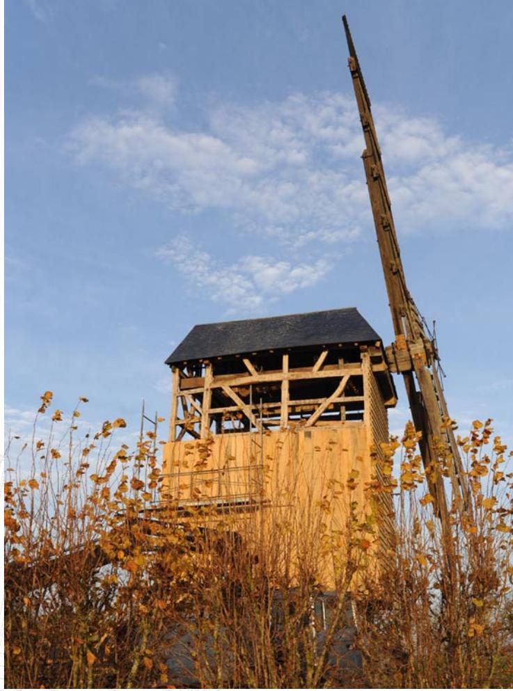
Les trattes inférieures ont pu être retournées et conservées. La sommière a été refaite à neuf et reposée sur le bourdon avec interposition d'un nouveau collet, ou "gateau".
